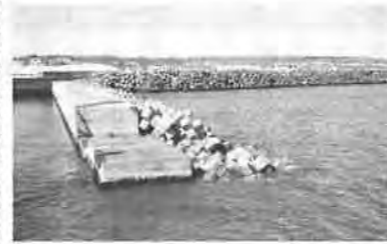
【工事】一般土木A 大樹漁港施設機能強化(補正)
