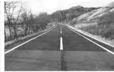
【工事】舗装・その他 津別陸別線地42改築(舗装補修工)
