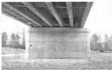
【工事】一般土木A 豊頃糠内芽室線防B508-3改良(新生橋補修工)
